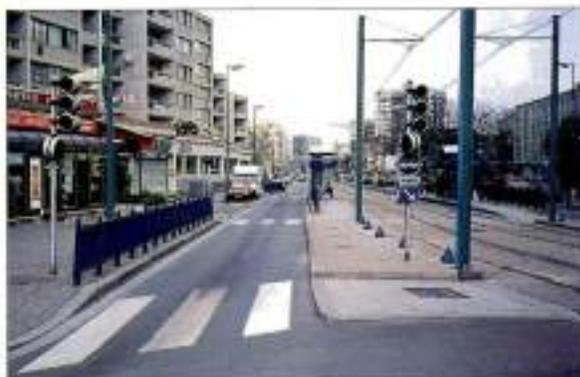
Station de tramway à Bouigny. Il est généralement préférable de ne pas équiper de feux la traversée du site tramway. En contrepartie la réalisation de traversées des voies routières aux deux extrémités de la station doit toujours être envisagée.
