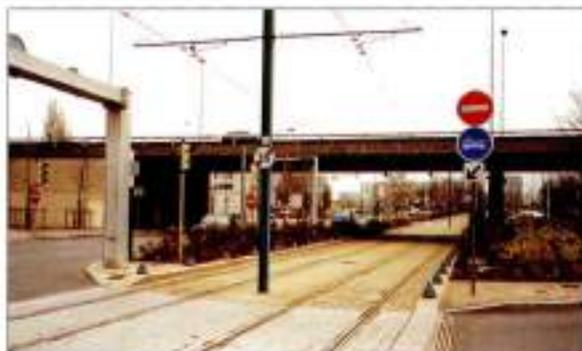
Abaissement d'une ligne aérienne à proximité du passage sous un ouvrage d'art.
